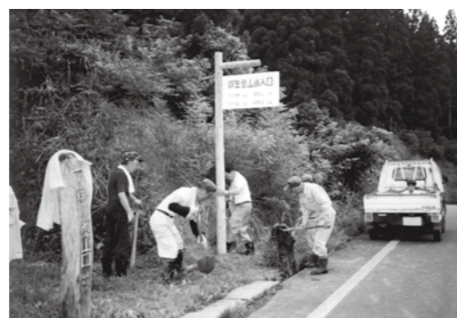
夏の日差しと草いされのなか、登山道入口に案内板を立てたときの様子。(1999年)
