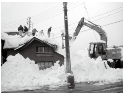
今冬の災害救助法による除雪の状況
