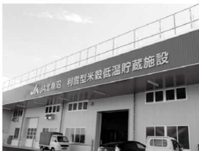
完成したJAの雪室
