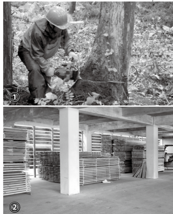
①間伐作業のようす ②製材した魚沼杉を乾燥している体育館のピロティは、杉の香りが広がります。
