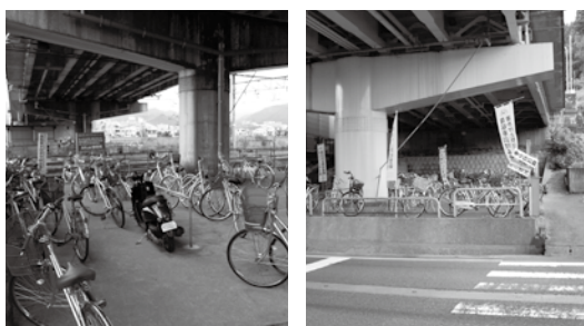
一部が使用できなくなる第1駐輪場(山側) 第2・第3駐輪場をご利用ください(JR上越線両脇)
