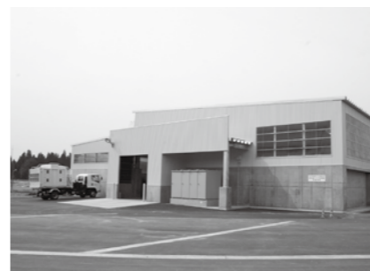
4月20日 魚沼市地域バイオマス利活用施設が運転開始 畜ふんなどの有機資源を発酵作用で安全なたい肥にしていける施設が完成しました。
