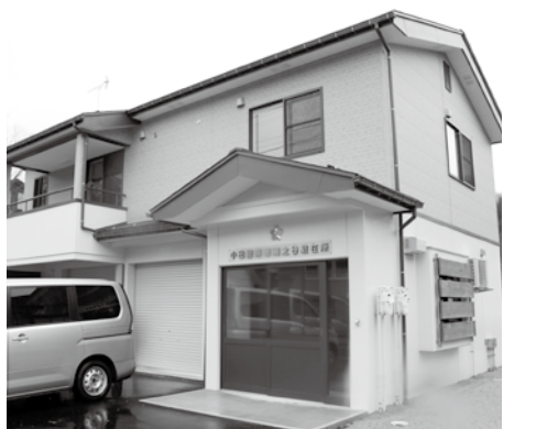
新築された湯之谷駐在所外観
