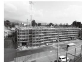
新庁舎の建設現場では、鉄骨が2階部分まで組み上がり、床及び壁面のコンクリート打設に向けた作業が行われています。今月からは、3階部分の鉄骨建て方工事が始まります。今後も新庁舎に関する情報は、市ホームページ等で随時お知らせしながら、コンパクトで雪に強く、市民の皆さんに愛される庁舎の完成を目指していきます。
