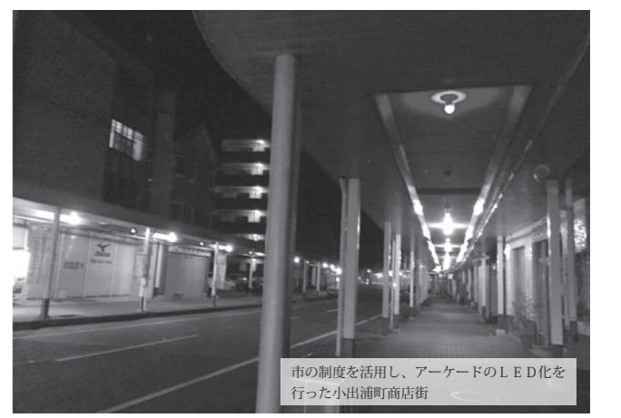
市の制度を活用し、アーケードのLED化を行った小出浦町商店街
