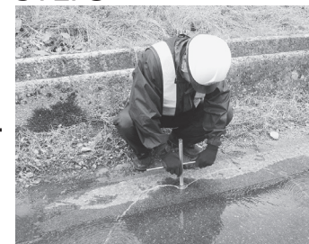
目詰まりをしている箇所を直して、水の出を良くします。
