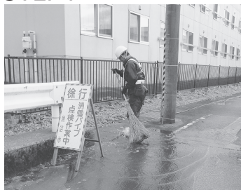
道路に泥水を残さないように、竹ぼうきで側溝へ流していきます。
