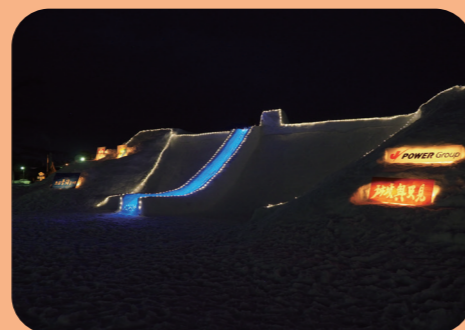
2.28 電気に、本気。未来を照らす奥只見ダム
