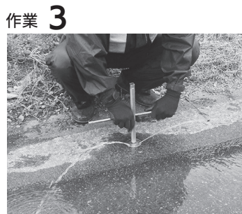
目詰まりをしている箇所を直して、水の出を良くします。
