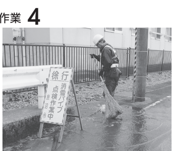
道路に泥水を残さないように、竹ぼうきで側溝へ流していきます。
