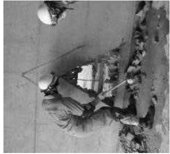
最後にコンクリートパネルの中にある鉄筋を曲げたり切断し開口部の作成が完了です。
