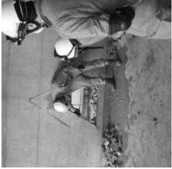
最後にコンクリートパネルの中にある鉄筋を曲げたり切断し開口部の作成が完了です。
