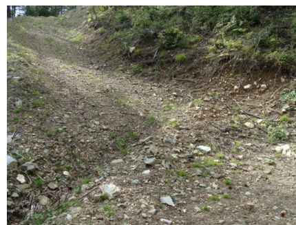
素掘りによる横断溝
