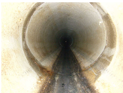
【管更生施工前】
