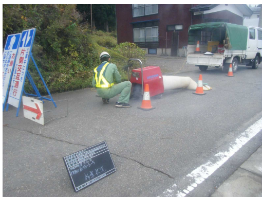
【送煙試験施工状況】
