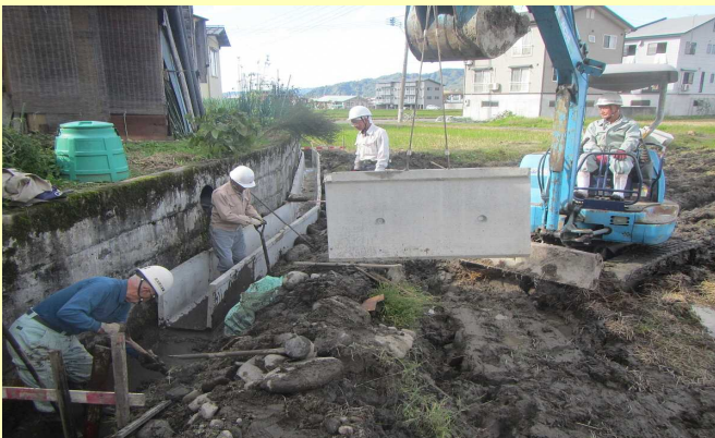
▲施設の長寿命化のための水路の更新、未舗装農道の舗装作業
