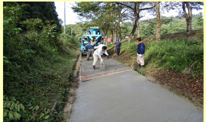
▲施設の長寿命化のための水路の更新、未舗装農道の舗装作業
