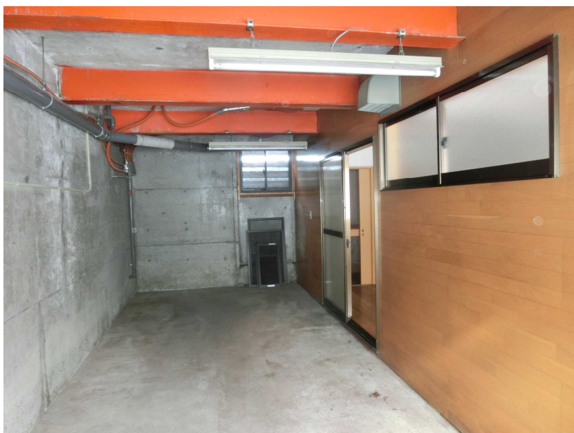
1階 物置 作業室入口
