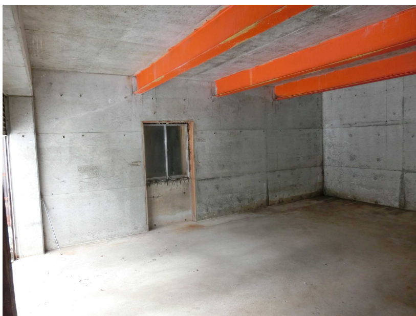
1 階 車庫 作業室窓
