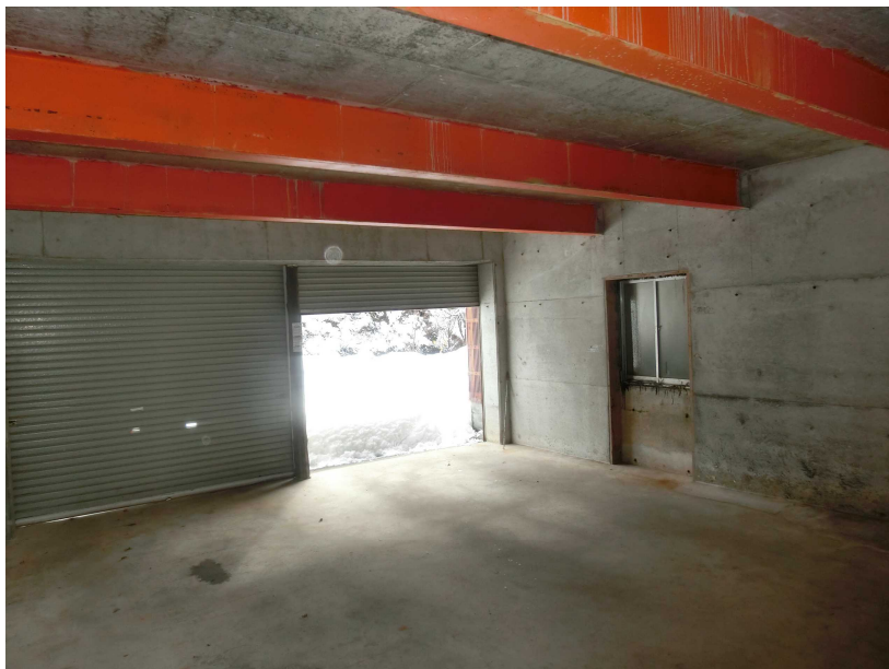
1 階 車庫 作業室窓
