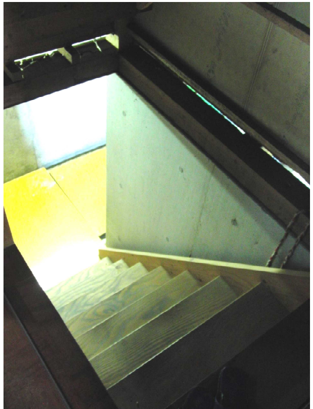
【1階から地下への階段】
