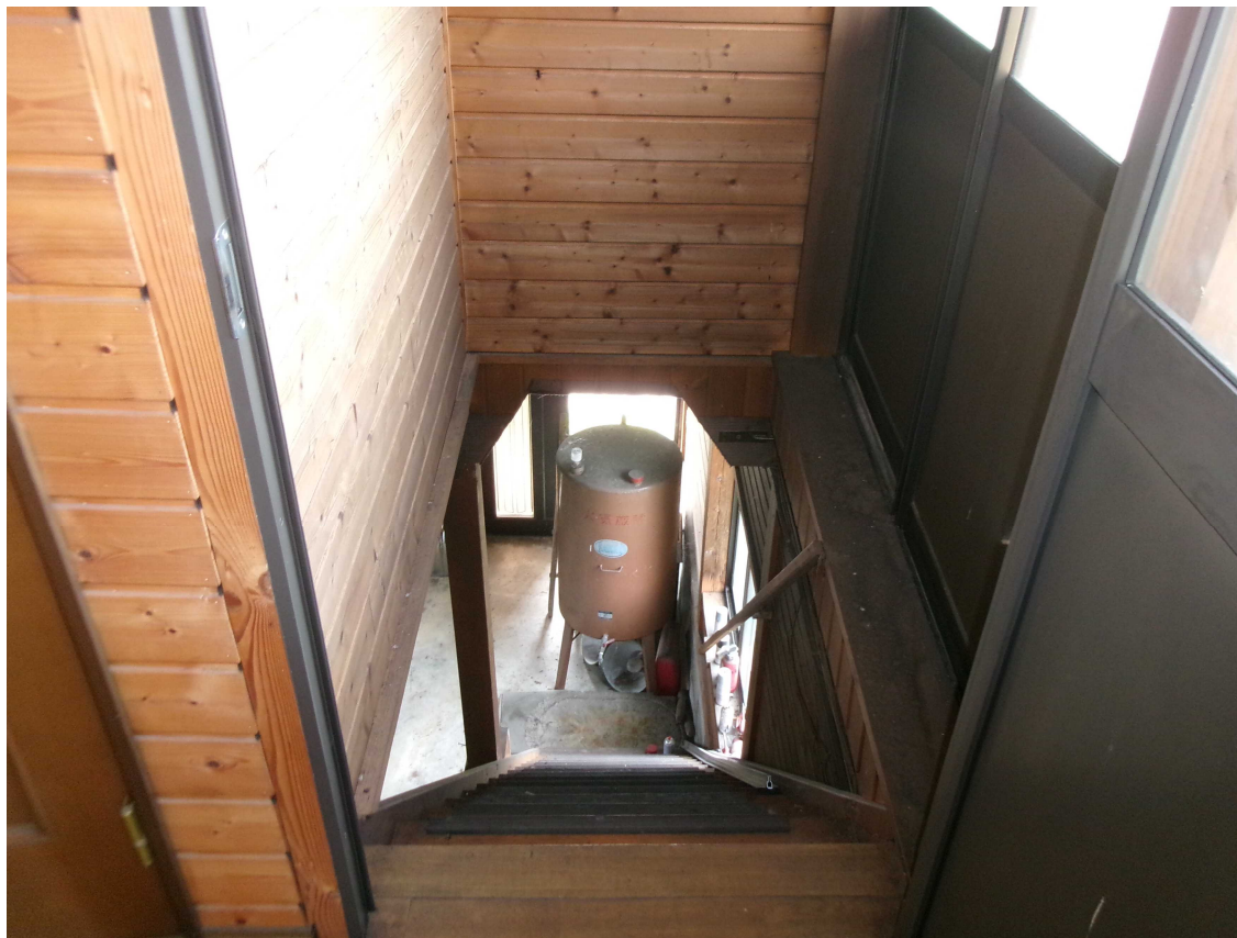
2階から 1階出入口への階段
