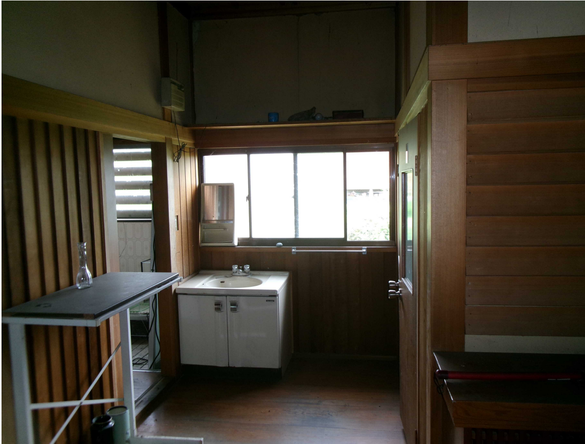
1階 洗面 浴室出入口 トイレ出入口
