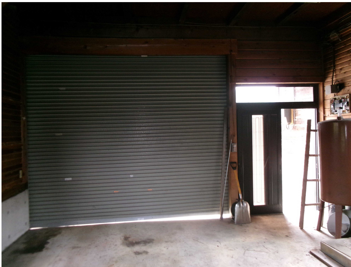
正面出入口 内側
