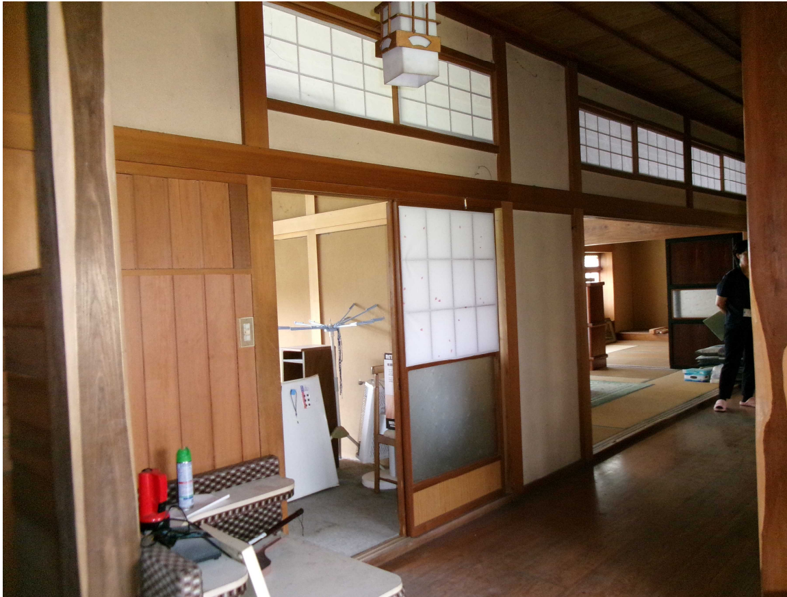
玄関から1階 廊下 和室出入口
