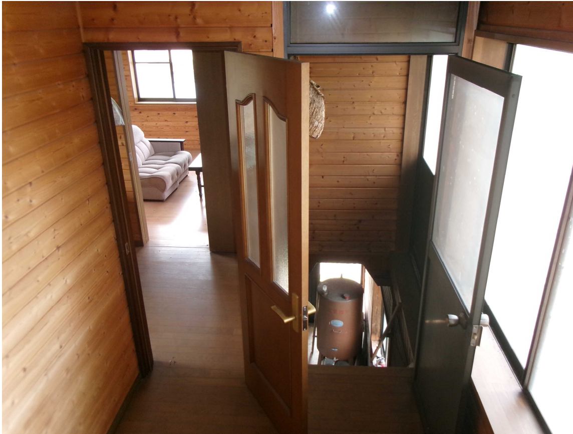
2階 ⑫ 洋室出入口 1階出入口からの階段 奥側⑪ 洋室出入口
