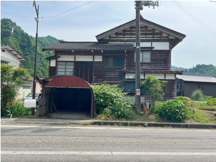
全景（北側、国道352号に接する）
