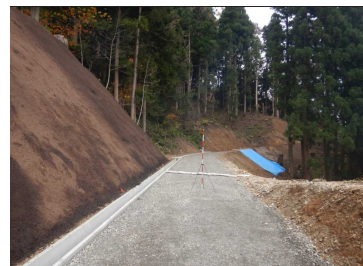
【森林整備事業】 品木沢森林作業道開設第1期工事
