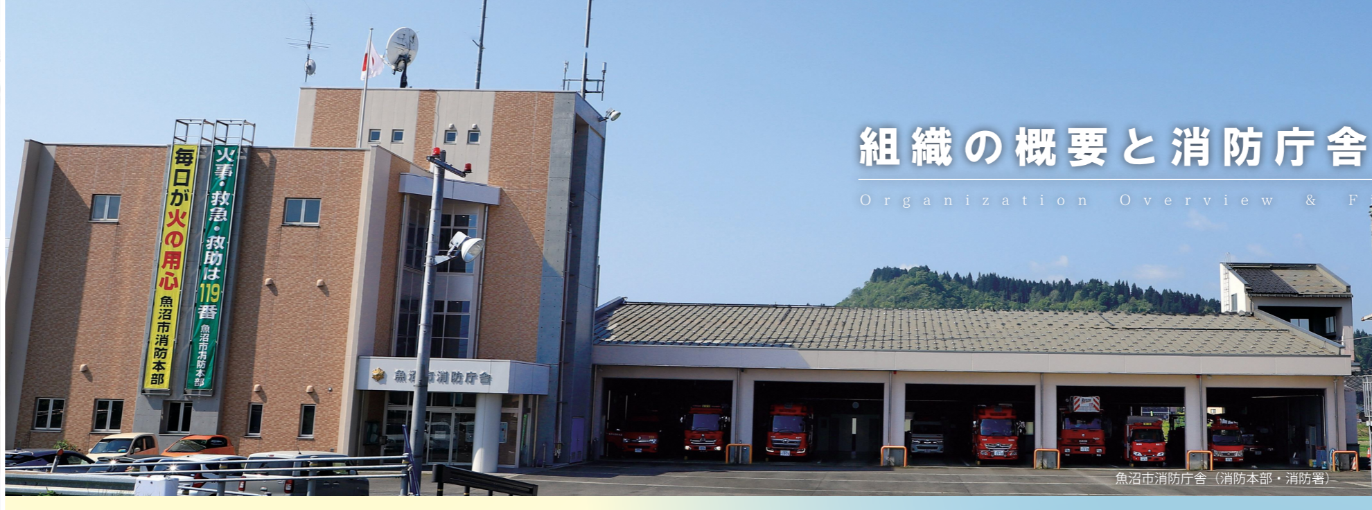
消防庁舎正面玄関
