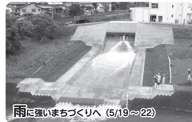
雨に強いまちづくりへ(5/19~22) 令和2年から内水対策事業として建設を進めてきた四日町排水ポンプの試運転が行われました。ポンプが稼働することにより、大雨の際に四日町周辺地域の浸水被害を軽減することができます。工事は、令和8年10月頃に完成を予定しています。
