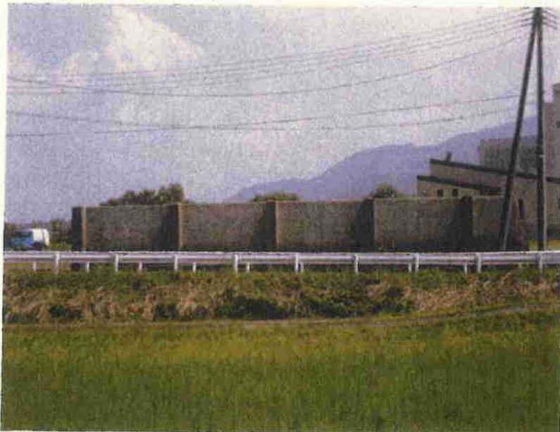
2廃工第2号 小出郷リサイクルハウス 解体撤去工事
