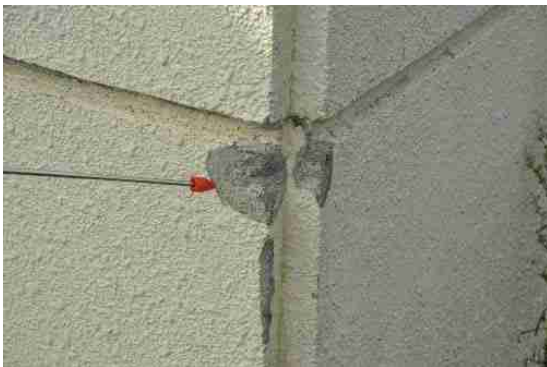
柱の破損
