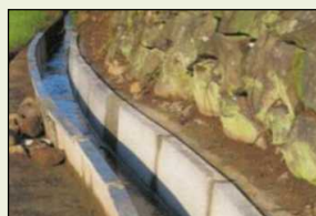
素堀り水路からの更新
