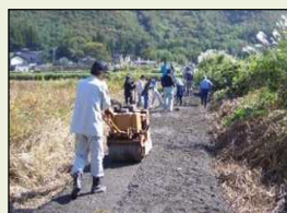
未舗装農道の舗装
