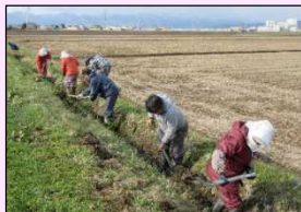
水路の泥上げ
