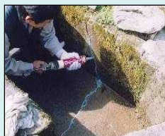
ひび割れの補修
