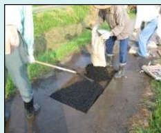
農道の部分補修
