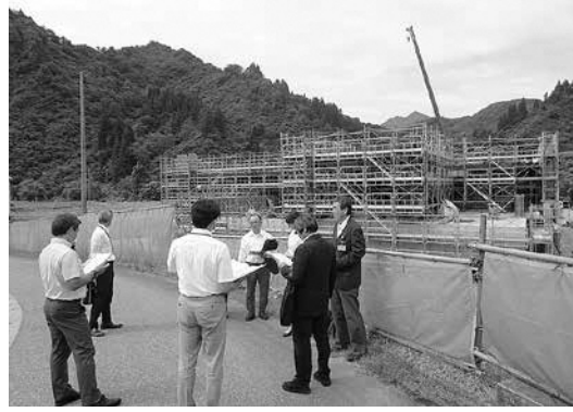
現地調査 魚沼市養護老人ホーム南山荘 (移転建設工事現場)
