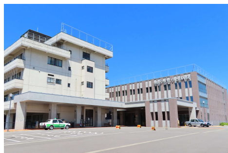
写真 病院敷地内の公共交通乗降スペースの事例 (小出病院)
