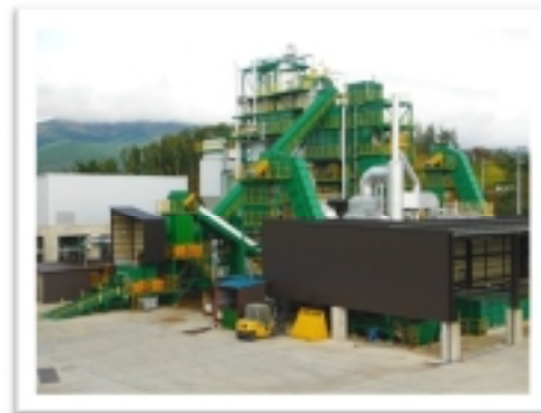
＜ 木質バイオマス発電所 ＞
