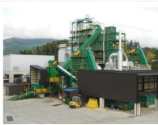
〈木質バイオマス発電所〉
