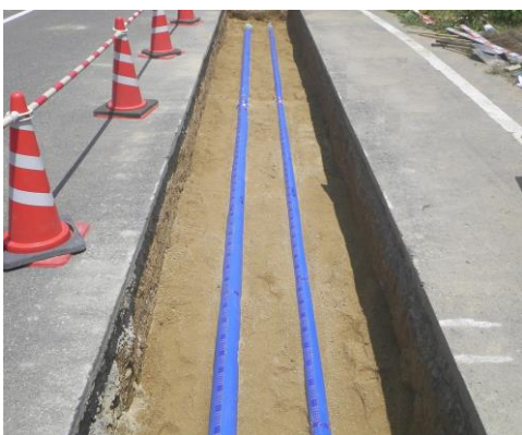
ポリエチレン管配管状況
