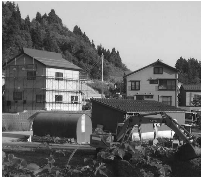
再建中の住宅
