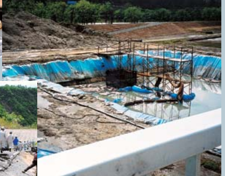
新道島下水処理場臨時汚水溜め
