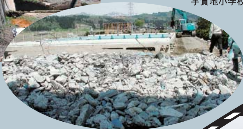
宇賀地小学校プール
