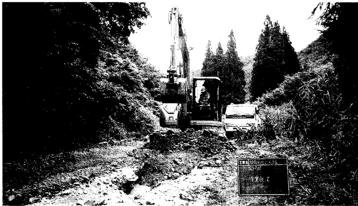
災害復旧工事現場
