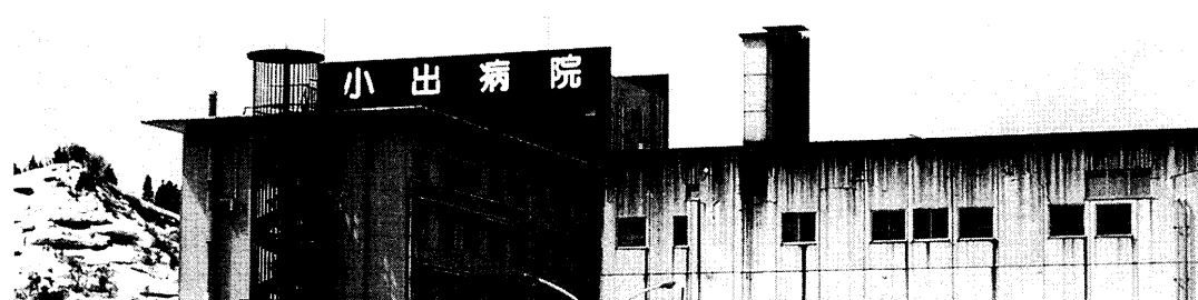
改修が待たれる小出病院東棟
