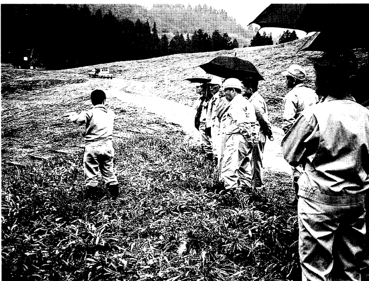
担当係員より被害状況の説明を受ける。(小出スキー場)
