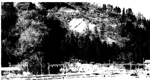
余震で斜面の亀裂が拡大、融雪による山崩れが心配されている。(堀之内地区下島)
