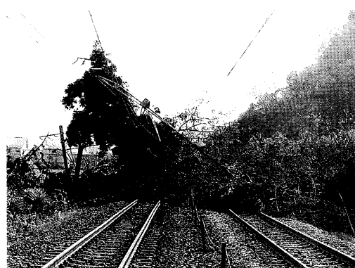
土砂崩れで不通となった上越線 (堀之内地区下島)
