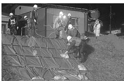
魚野川夜間水防訓練
