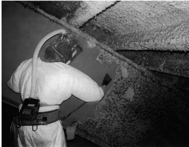
広神中学校体育館アスベスト除去工事
