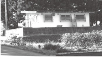
田川入第2配水池
