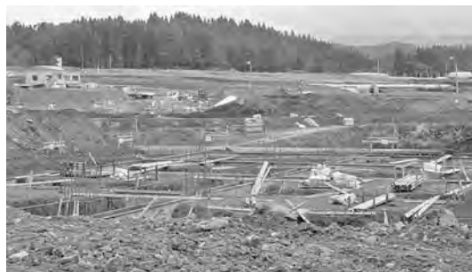
建設中の有機センター
