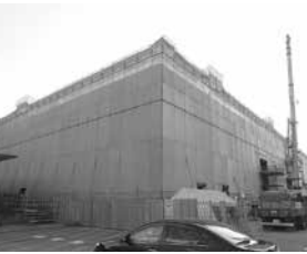
建設中の新小出病院
