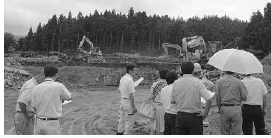
新斎場建設工事現場
