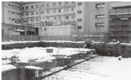
新小出病院建設現場
