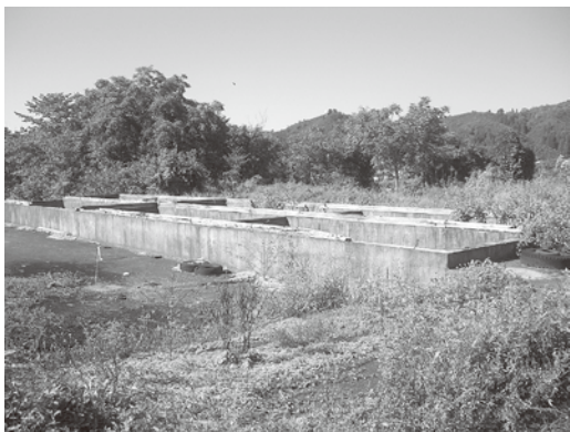
新斎場建設予定地
