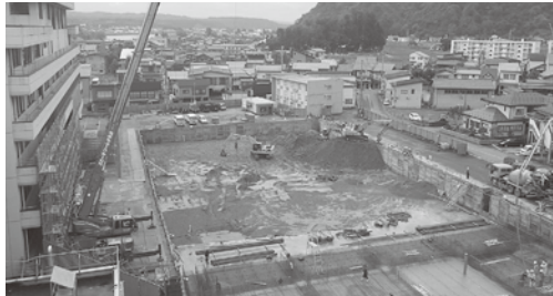
建設が進む新小出病院
