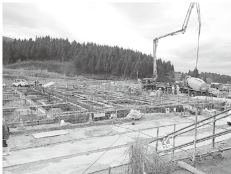
斎場建設工事現場
