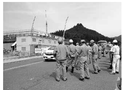
湯之谷小学校建設工事
