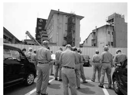
小出病院解体工事
