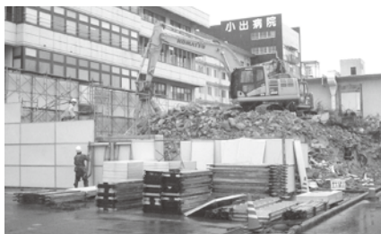
小出病院 解体工事現場
