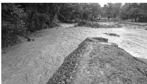
7月18日大雨により決壊した増沢川
