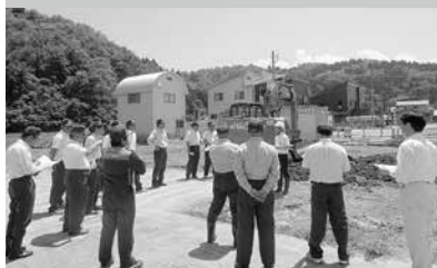
国道17号バイパス工事現場
