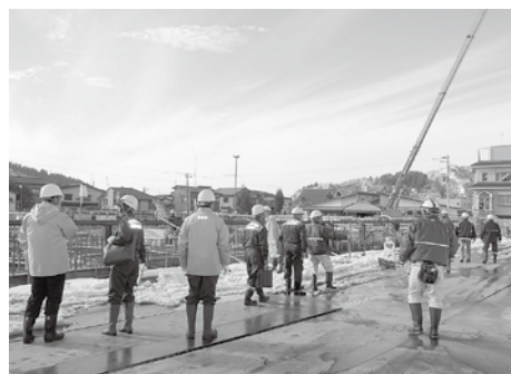
新庁舎建設現場
