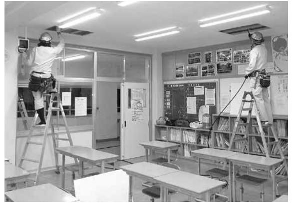
エアコン設置工事（湯之谷中学校）
